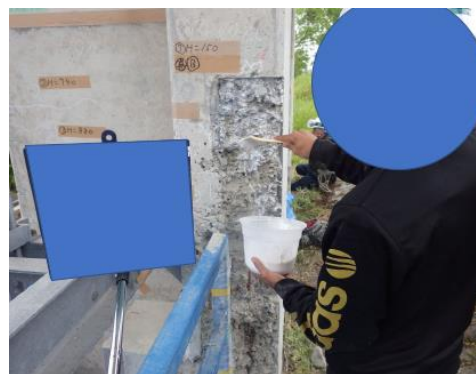
写真-4 プライマー塗布
