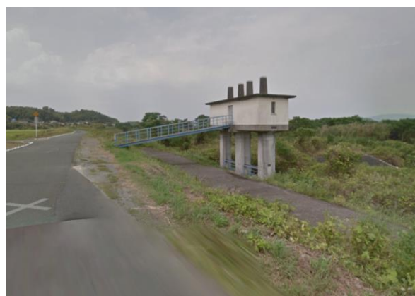
写真-2 排水樋門全景
