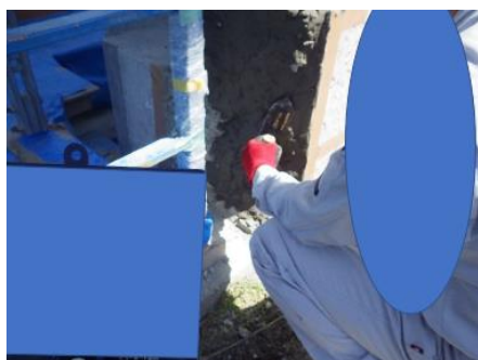
写真-5 モルタル充填状況
