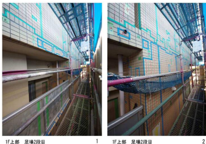
写真-1 打診調査状況
