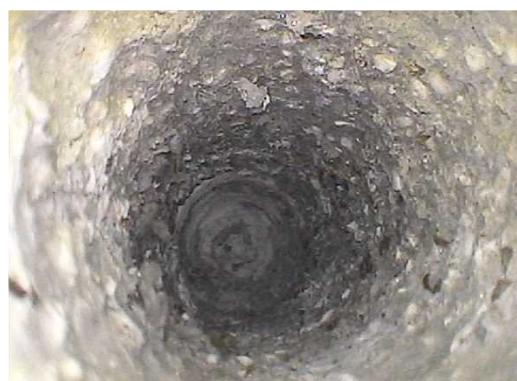
削孔状況（孔内）
