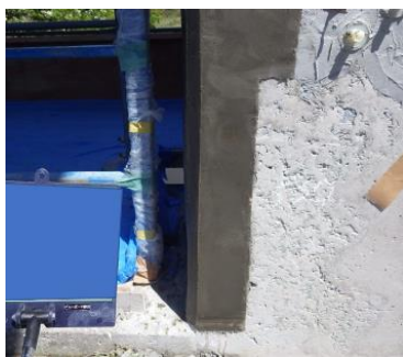
写真-6 モルタル充填完了
