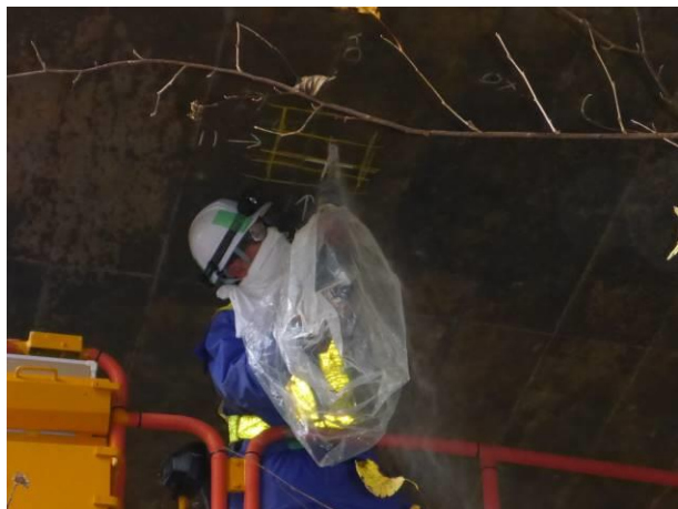
写真 5. ドリル削孔状況
