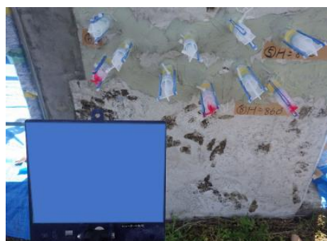
写真-8 注入完了
