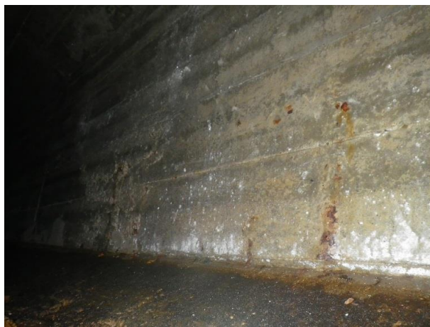
写真 8. 箱桁内部側面の状況
