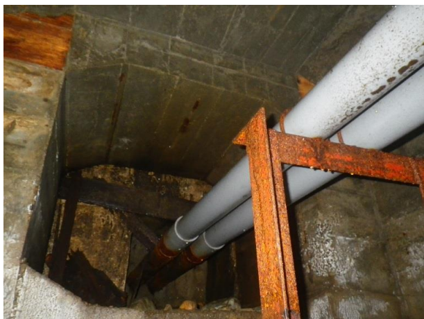
写真 7. 端横桁部の開口
