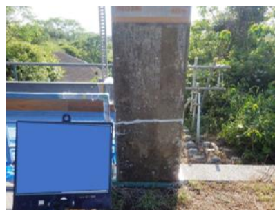
写真-11 プライマー塗布完了
