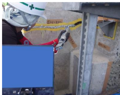
写真-9 充填状況
